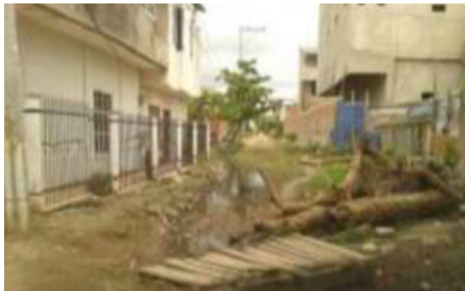
Canal que surte al Humedal desviado por la Comunidad
