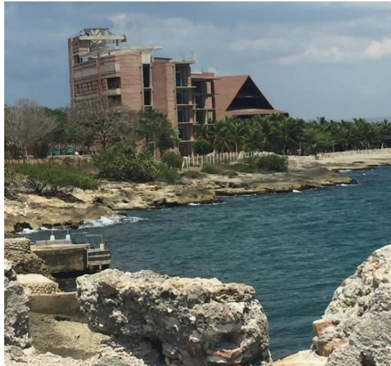
Figura 05: Construcción en Tierra Bomba
